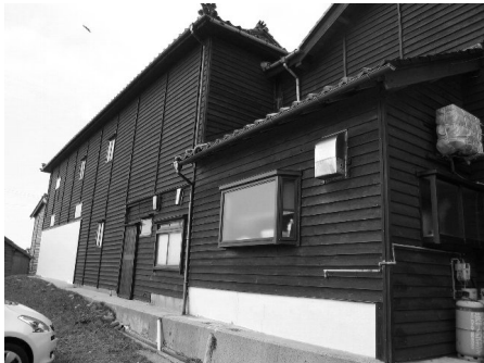
写真1 黒島地区の代表的な外観を持つ住宅(海側から山側に向けて撮影)
