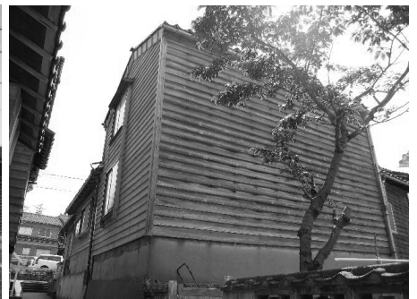
写真3 黒島地区の土蔵 OUD 邸(海側から山側に向けて撮影)
