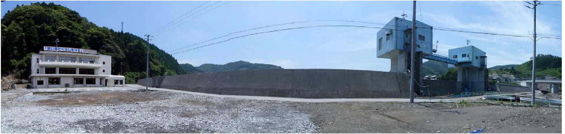
綾里漁港に整備された堤防
