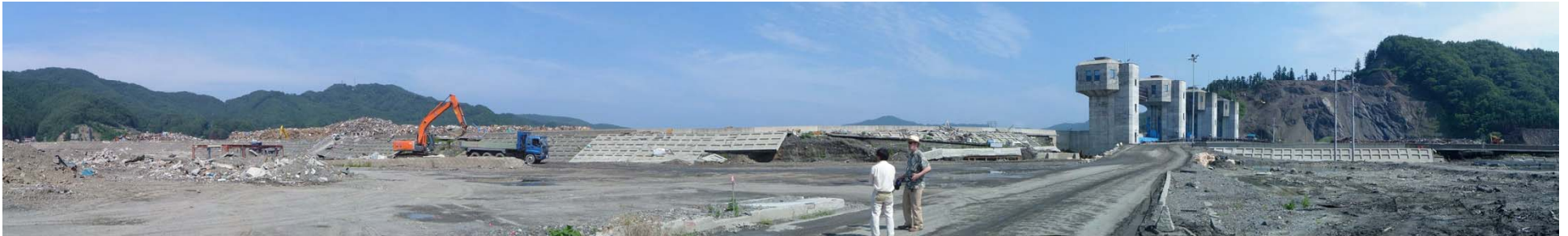
小槌川の堤防と水門
