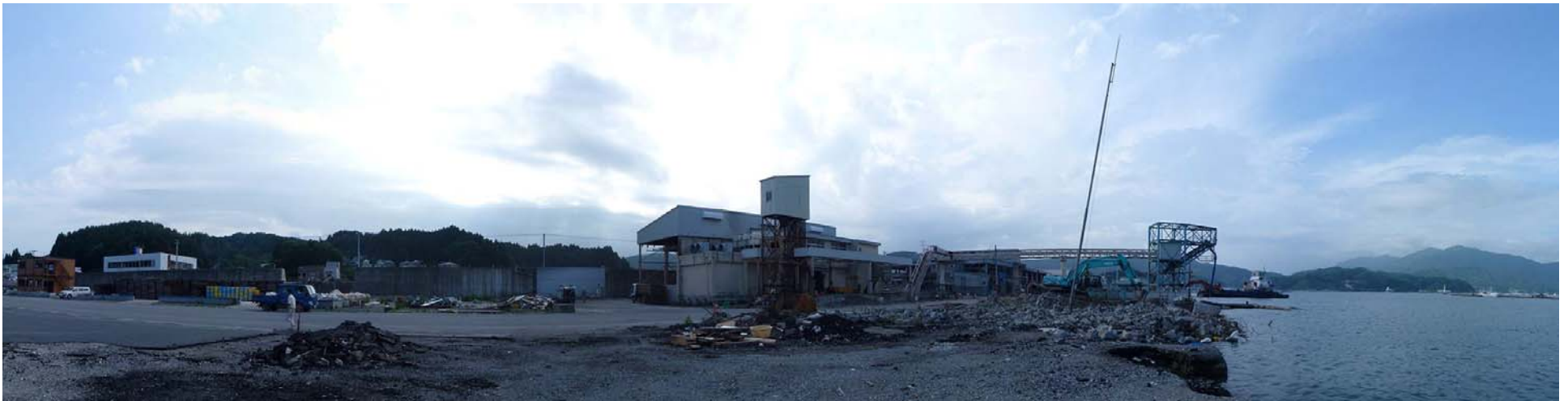
山田漁港堤防(地上から約4m)。一部は大きく破壊していた
