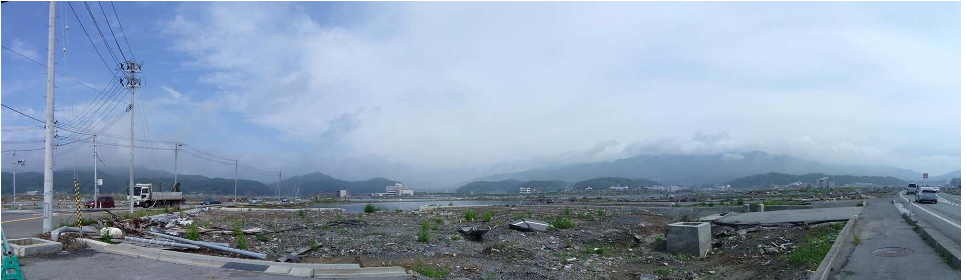
45号線と340号線の交差点より北東側を望む
