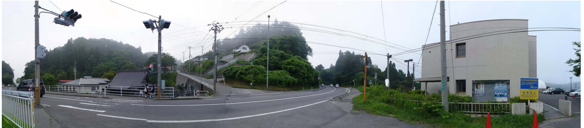
宮古測候所(右端)。建物内に気象庁の地震観測点
