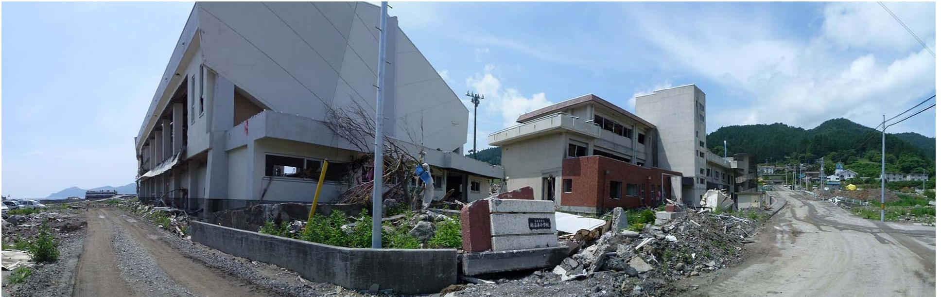
津波で大きな被害を受けた越喜来小学校
