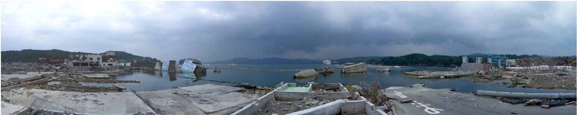
港の先端より、南側を望む かつてはこの先に埠頭があった
