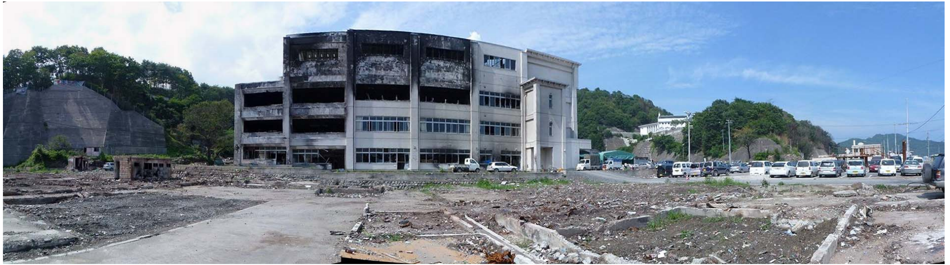
大槌小学校。火災で黒く焼けている
