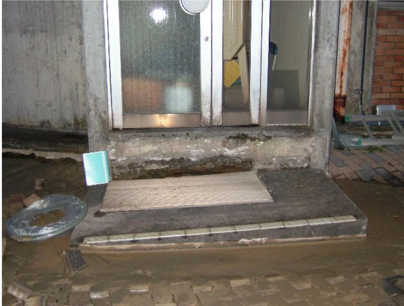
裏玄関の階段が沈下して建物との間に20センチぐらいの隙間が発生した。地面には泥水があふれている。
