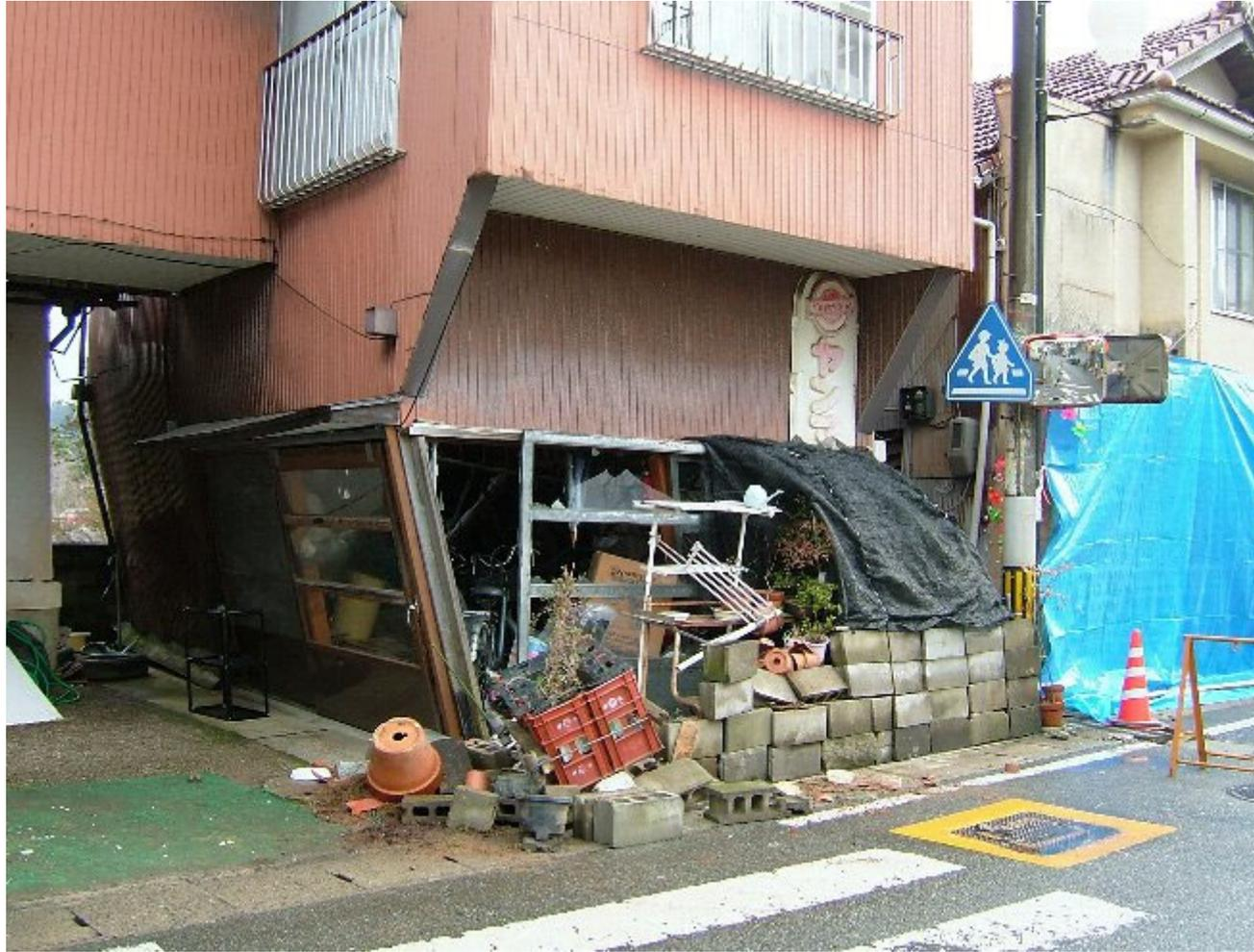
一階が大きく傾き、ブロック塀も倒れている。
