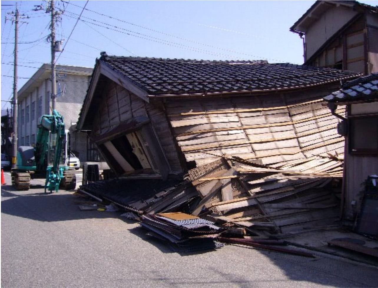
全壊した建物。地震発生翌日にすでにブルドーザーによって整理されている。
